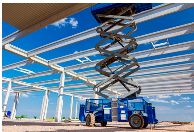
Messung der Hubhöhe in Scherenarbeitsbühnen
